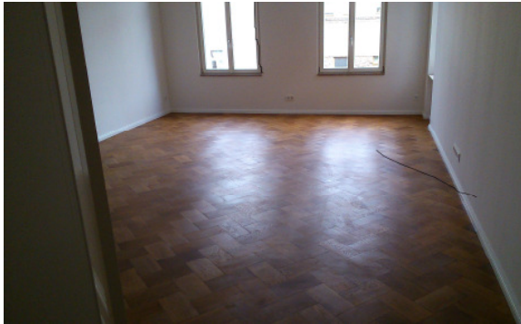
Reinigung einer Leerwohnung
